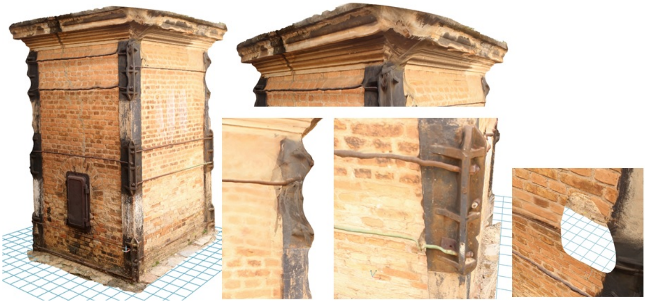
Fig. 6. Resultado do processamento realizado no Autodesk Recap Photo (fonte: elaborado pelos autores).
