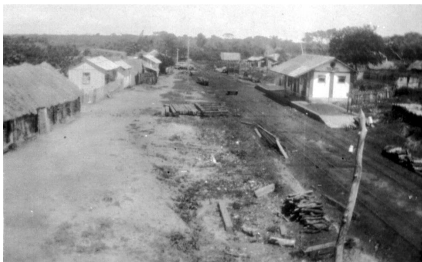
Figura 114 Esplanada de Salobra em obras
