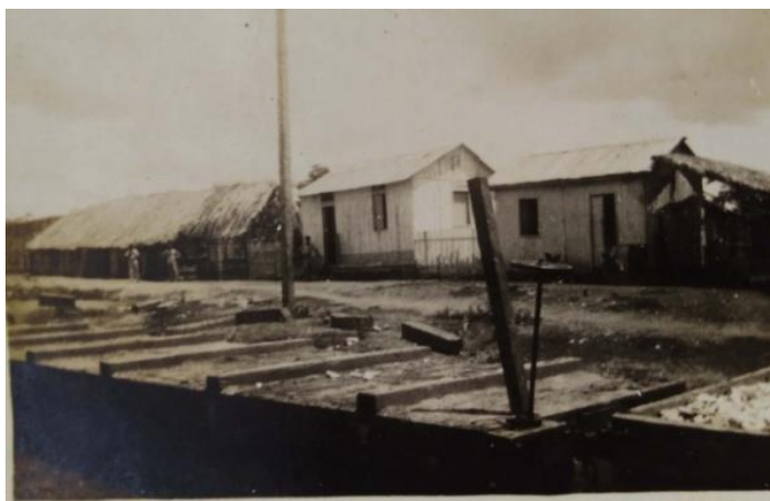
Figura 94 Arranchamento com tipologia de casas de madeira e telhado de zinco, Salobra/MS
