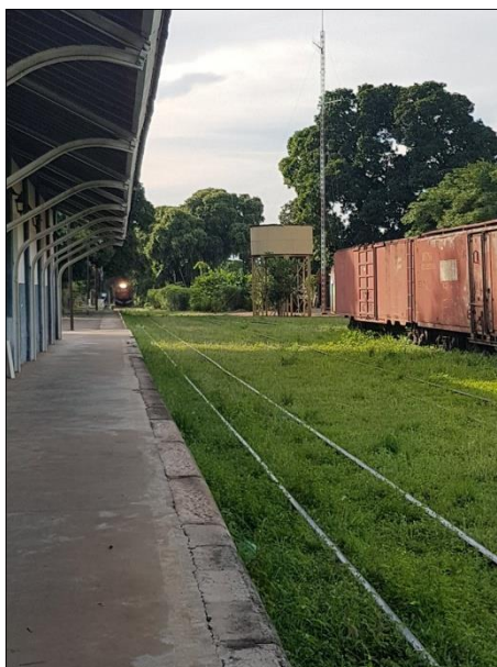
Figura 47 Vista da caixa d'água a partir da plataforma da estação de Miranda
