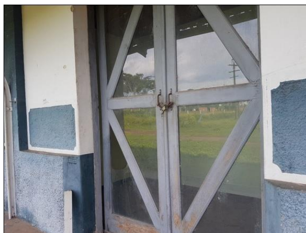
Figura 83 Porta que segundo Maura foi substituída por outra com fechamento em vidro
