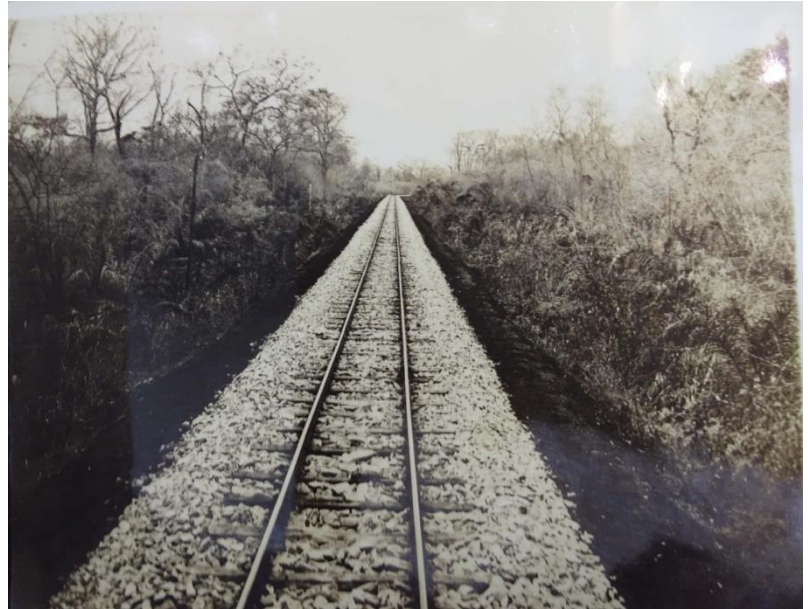
Figura 4 Empedramento da linha férrea (trecho entre Miranda e Corumbá)
