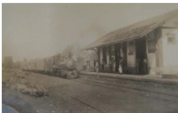
Figura 115 Vista da plataforma de embarque da estação de Salobra
