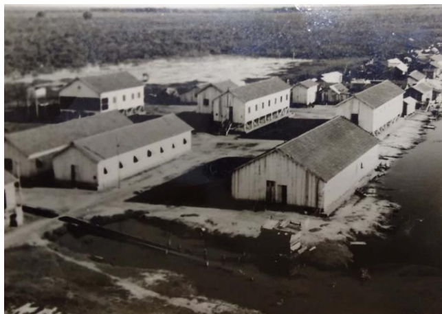
Figura 26 Vista geral de um acampamento de melhor qualidade, usado pelos operários da EFNOB no trecho de Corumbá
