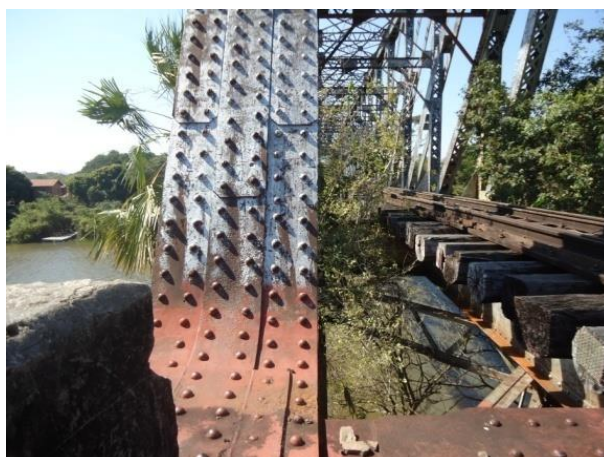
Figura 122 Detalhe de rebites na ponte sobre o rio Miranda
