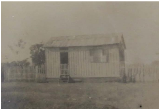
Figura 93 Vista de casa de madeira destinada aos engenheiros da EFNOB, Salobra/MS
