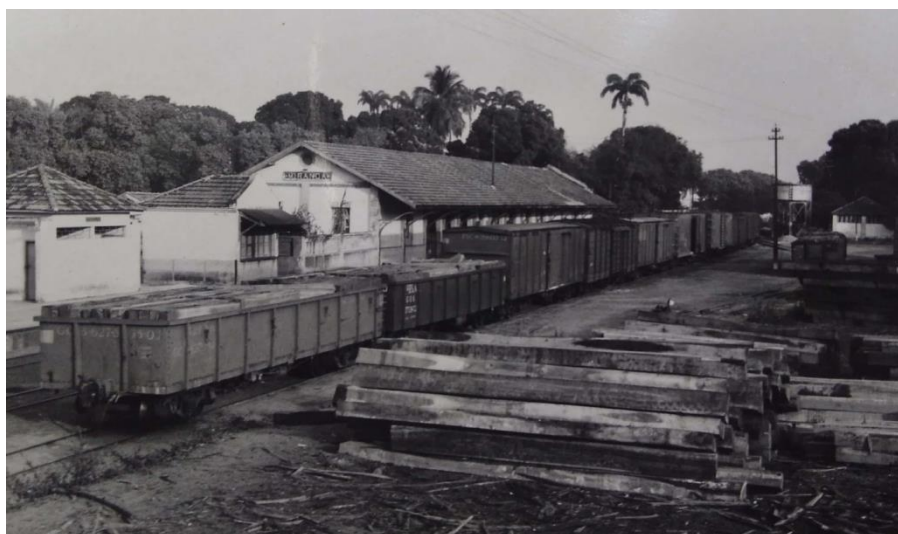
Figura 74 Vista do banheiro na plataforma (canto, à esq.)
