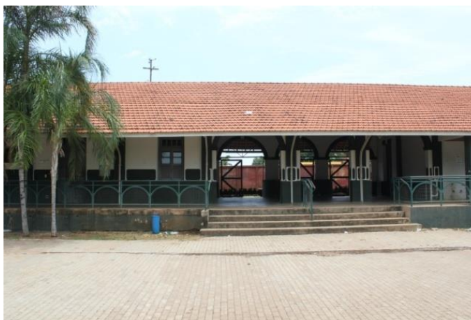
Figura 66 Acesso da estação de Miranda
