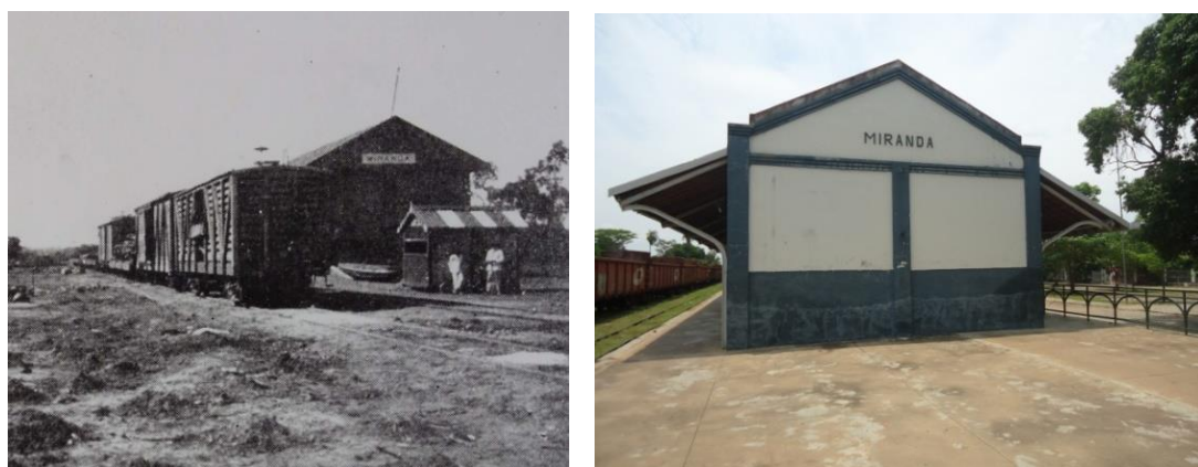
Figura 62 Detalhe da fachada lateral da estação de Miranda
