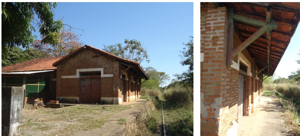
Figura 109 Detalhe dos tijolos aparentes da estação e das tesouras de madeira da cobertura da plataforma
