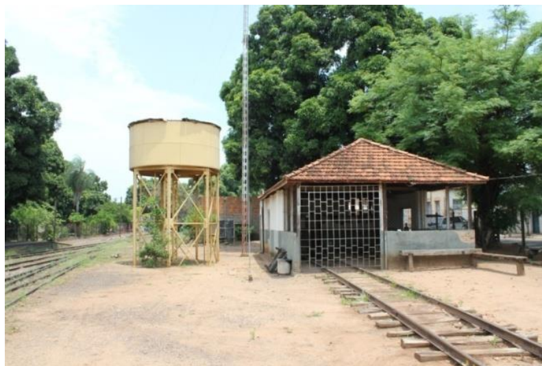
Figura 49 Caixa d'água ao lado da casa de bombas em Miranda
