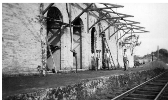
Figura 31 Obras de estação da EFNOB em MS [estação não identificada]
