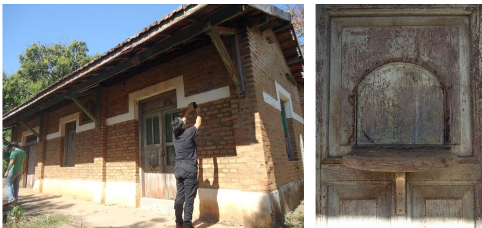
Figura 107 Detalhe de portinhola do telégrafo
