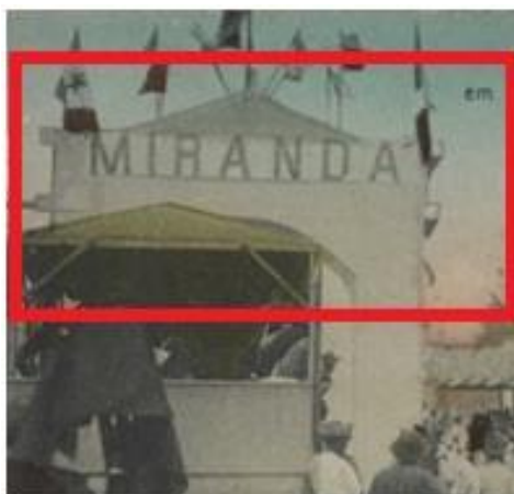
Figura 64 Detalhe de platibanda na fachada da estação de Miranda
