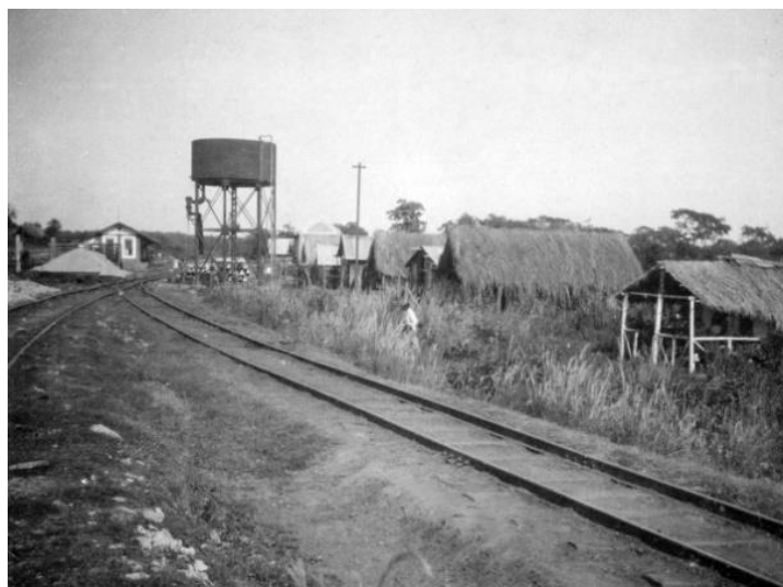
Figura 91 Vista da caixa d'água no arranchamento para operários da EFNOB em Salobra
